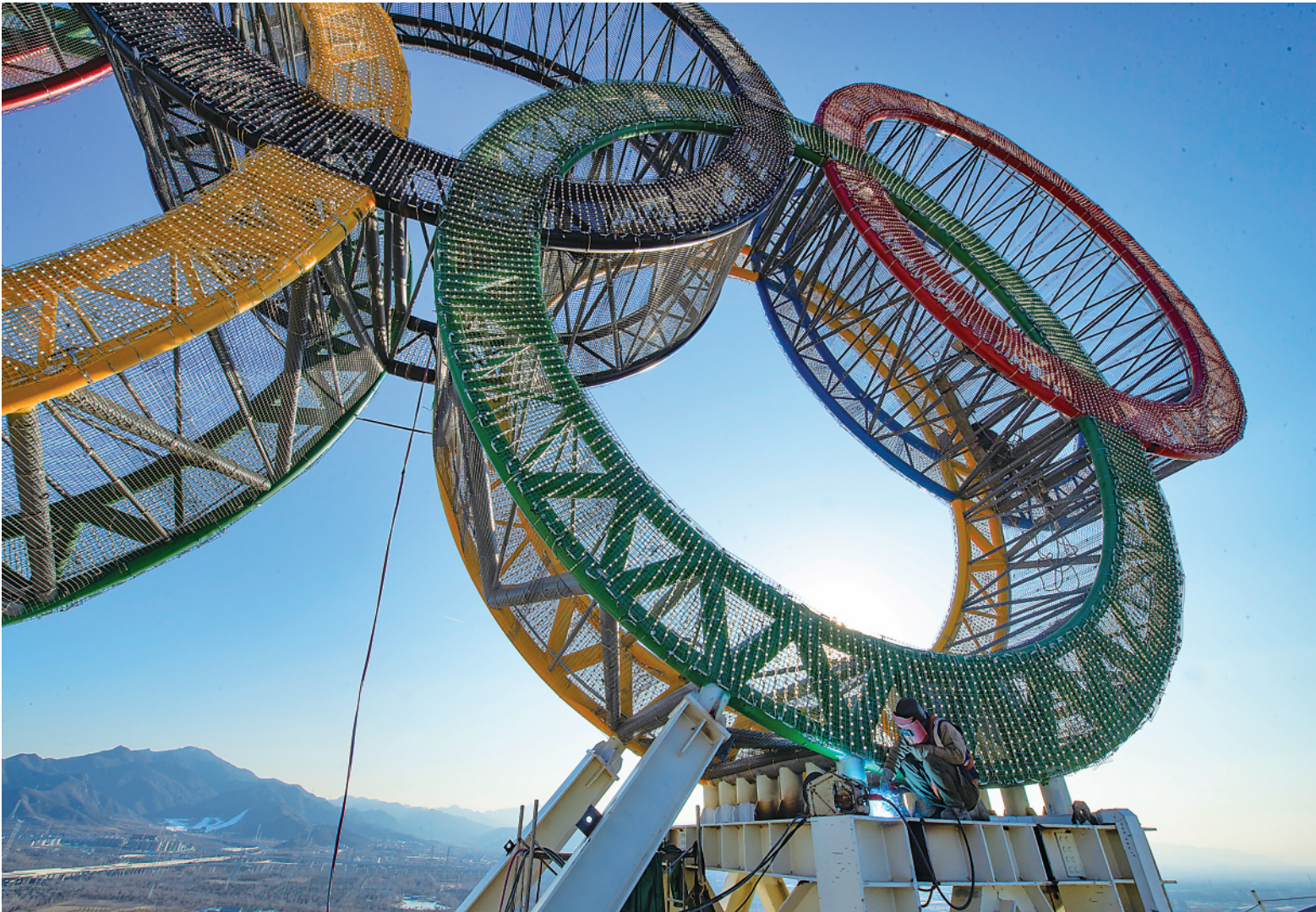
▲ 1 月 11 日,工人们在“海陀塔”塔顶的奥运五环标志下作业。 近日,位于北京冬奥会延庆赛区的“海陀塔”上的奥运五环结构吊装作业完成,进入工程收尾阶段。塔顶设置奥运五环标志,表面安装了共计 7 万余个白色点光源,塔身加装飘带形装饰。据介绍,“海陀塔”预计 2022 年 1 月底前完工,届时将在夜间点亮灯光景观,成为北京冬奥会标志性景观之一。 新华社记者陈钟昊摄
