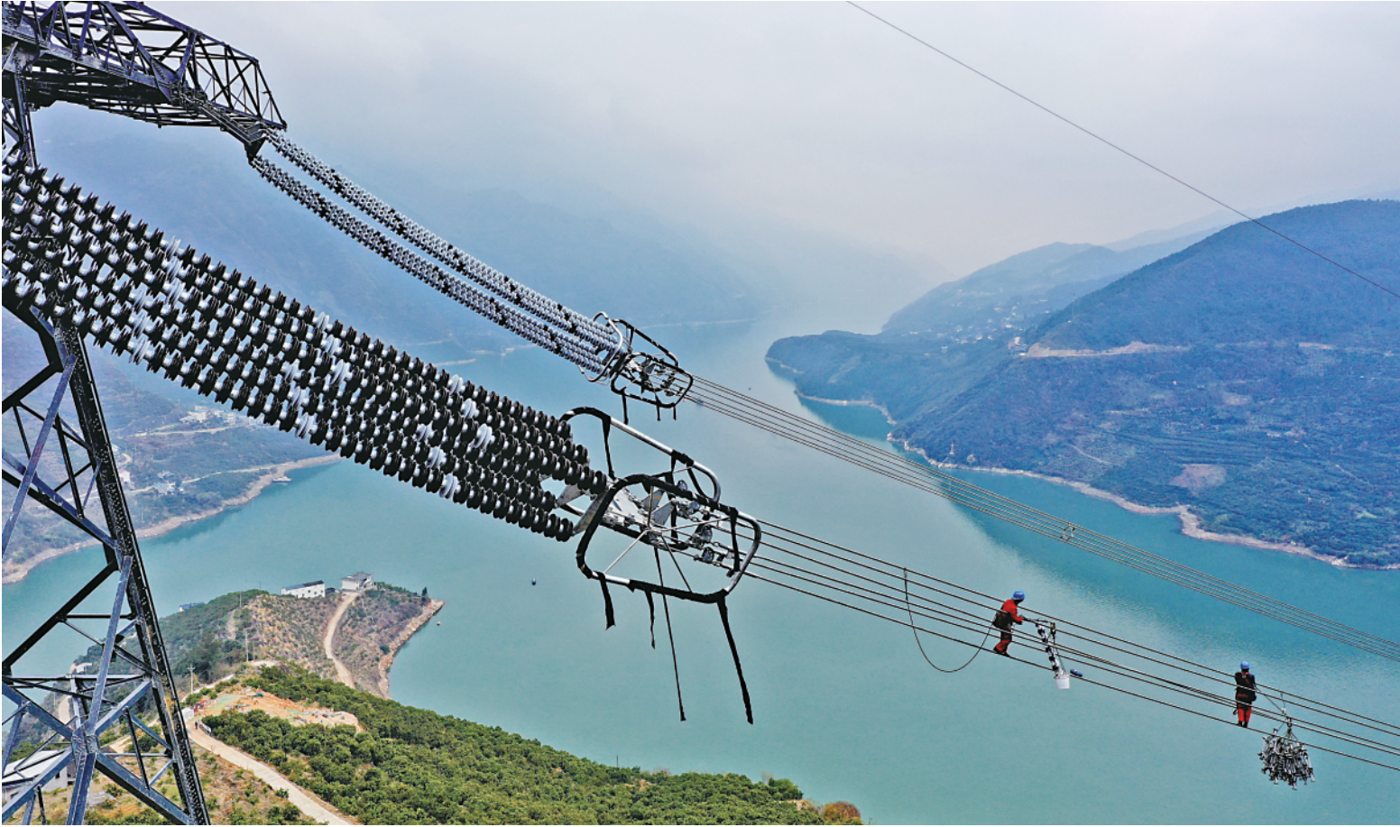
▲1月10日,在湖北秭归,施工人员在跨越长江的线路上安装间隔棒。白鹤滩—江苏±800千伏特高压直流输电工程于2020年12月开工。工程线路全长2087公里,途经四川、重庆、湖北、安徽、江苏,新建白鹤滩、虞城2座换流站。工程额定电压±800千伏、额定输送容量800万千瓦,总投资307亿元,计划于2022年建成投运。
