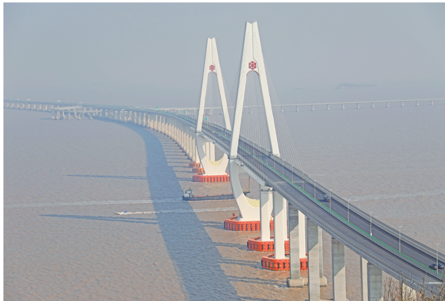
12月29日拍摄的舟岱大桥。
