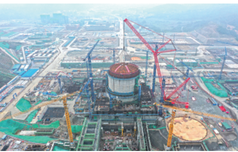
24日,广东太平岭核电项目1号机组顺利完成穹顶吊装,标志着1号机组项目从土建施工阶段全面转入设备安装阶段。新华社发
