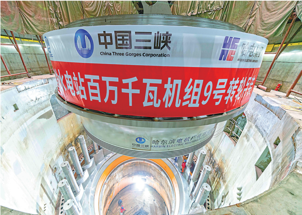
白鹤滩水电站最后一台机组——9号水轮发电机组转轮日前顺利完成吊装。至此,白鹤滩水电站16台百万千瓦水轮发电机组转轮全部吊装完成,标志着全部机组投产进入倒计时。白鹤滩水电站是实施“西电东送”的国家重大工程,总装机容量仅次于三峡工程。新华社发(张禾摄)
