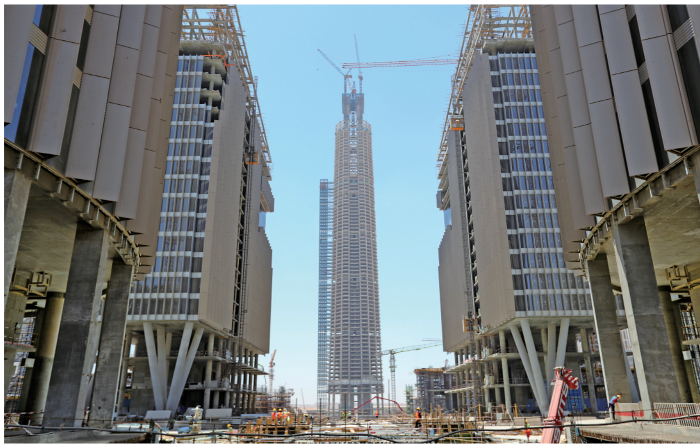
这是六月十七日在埃及开罗附近拍摄的埃及新行政首都中央商务区标志塔(中)。
