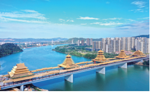
近日,广西柳州凤凰岭大桥进入施工冲刺阶段,即将完成铜瓦铺设的大桥仿佛披上一层金色的外衣(11月24日摄)。新华社发(黎寒池摄)
