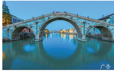
浙江省湖州市南浔区双林镇的万元、化成、万魁三桥矗立在水面上，与波光粼粼的塘河交相辉映，远眺桥中见桥，风貌独特。沈勇强/摄
