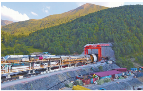
中国制造的全球最大直径全断面硬岩掘进机“高加索号”日前在格鲁吉亚组装完毕并投入使用。
