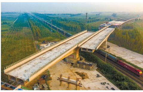
9月10日,河北滦州境内的迁(安)曹(妃甸)高速跨京哈铁路双桥转体成功,与高速主路实现精准对接。新华社记者杨世尧摄
