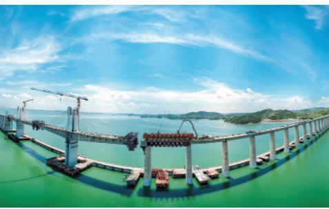
9月6日,新建福厦铁路湄洲湾跨海大桥最后一孔移动模架完成首次海上高铁架梁任务。 新华社记者宋为伟摄
