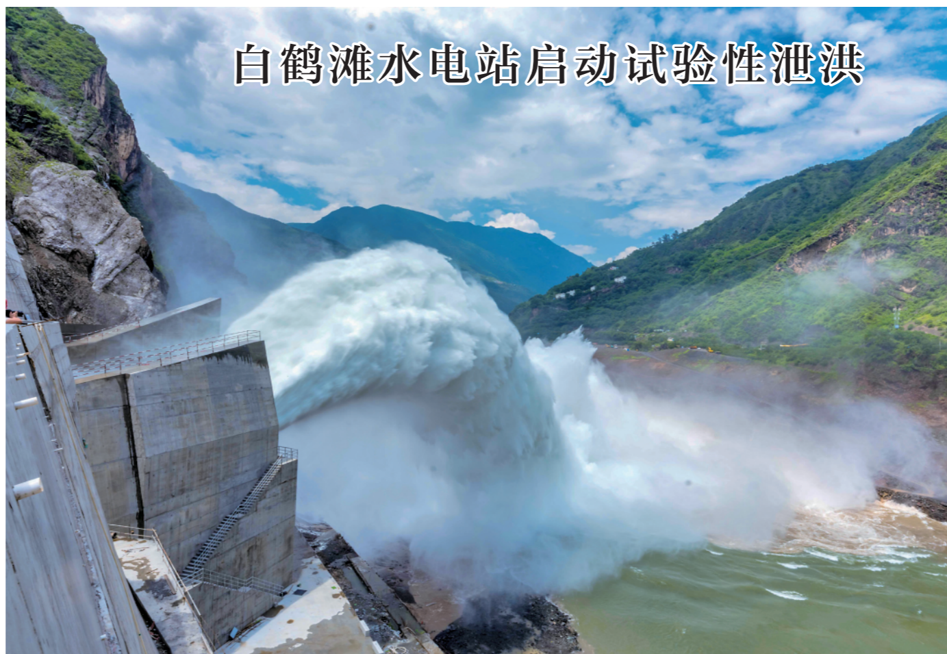
正在进行的试验性泄洪的白鹤滩水电站(九月二日摄)。白鹤滩水电站泄洪工程日前启动试验性泄洪，为后续工程安全度汛奠定了坚实基础。新华社发(谢雷摄)
