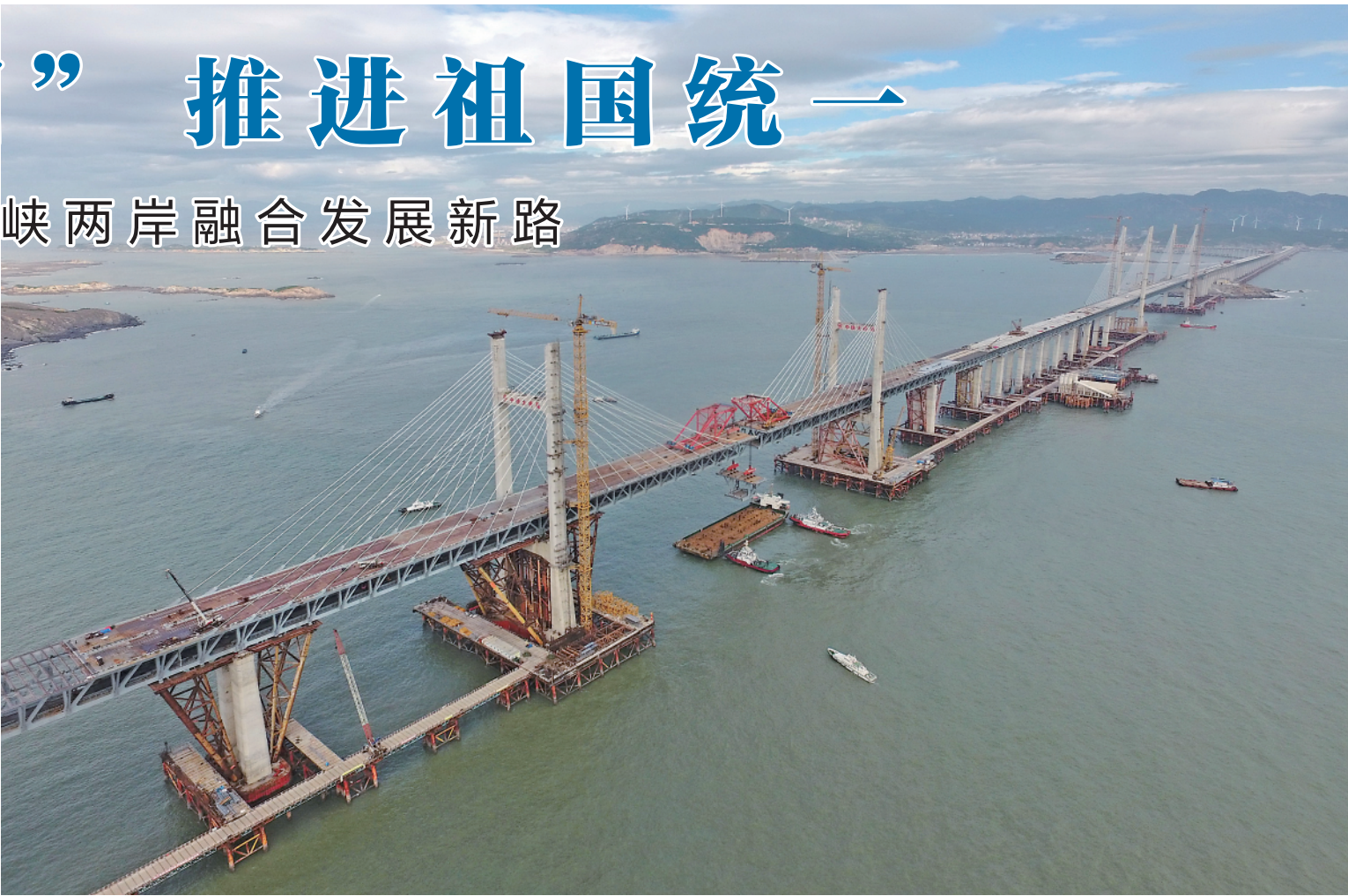
2019年9月25日，总长16.34公里的平潭海峡公铁大桥合龙贯通。平潭海峡公铁大桥是福州至平潭铁路控制性工程，也是北京至台湾高铁的先期工程。
