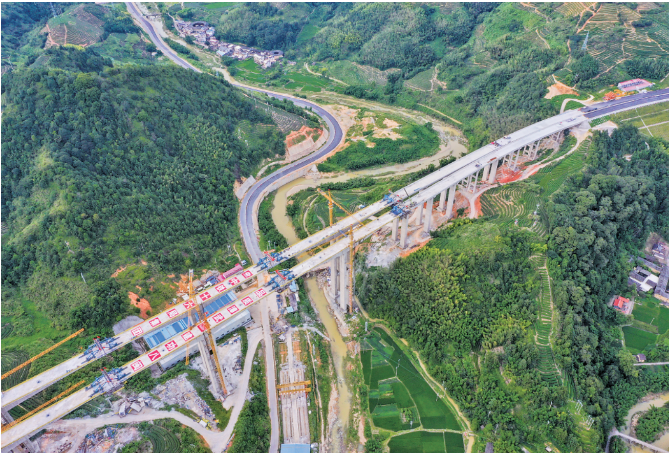
建设中的书洋特大桥(8月23日摄，无人机照片)。8月24日，由中铁十六局集团承建漳(州)武(平)高速公路重难点及控制性工程——书洋特大桥主桥顺利合龙，该桥是全线首座合龙的大跨度桥梁。书洋特大桥采用双向四车道高速公路标准，设计时速100公里，全长1074米，主墩高86米。 新华社发(许鹏健摄)
