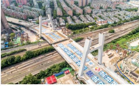
8月18日,全长519.3米的武汉建安街上跨铁路桥东主塔墩梁体转体到位。 新华社发(伍志尊摄)
