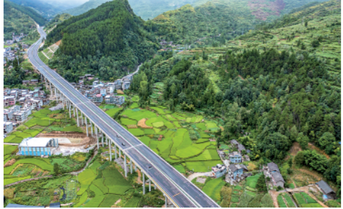
8月15日,车辆行驶在秀印高速公路小湾大桥上。当日,秀山至印江高速公路(贵州段)正式通车。新华社记者陶亮摄
