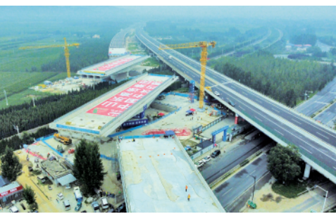
8月9日,京台高速泰安至枣庄段改扩建项目跨京沪铁路双T构转体桥在空中实现精准对接。 新华社记者范长国摄
