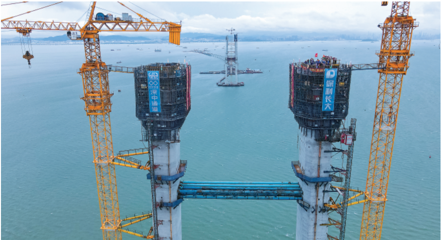
广东省中山市深中通道建设工程伶仃洋大桥西索塔封顶现场（七月十九日摄） 新华社发（陈旭彬摄）
