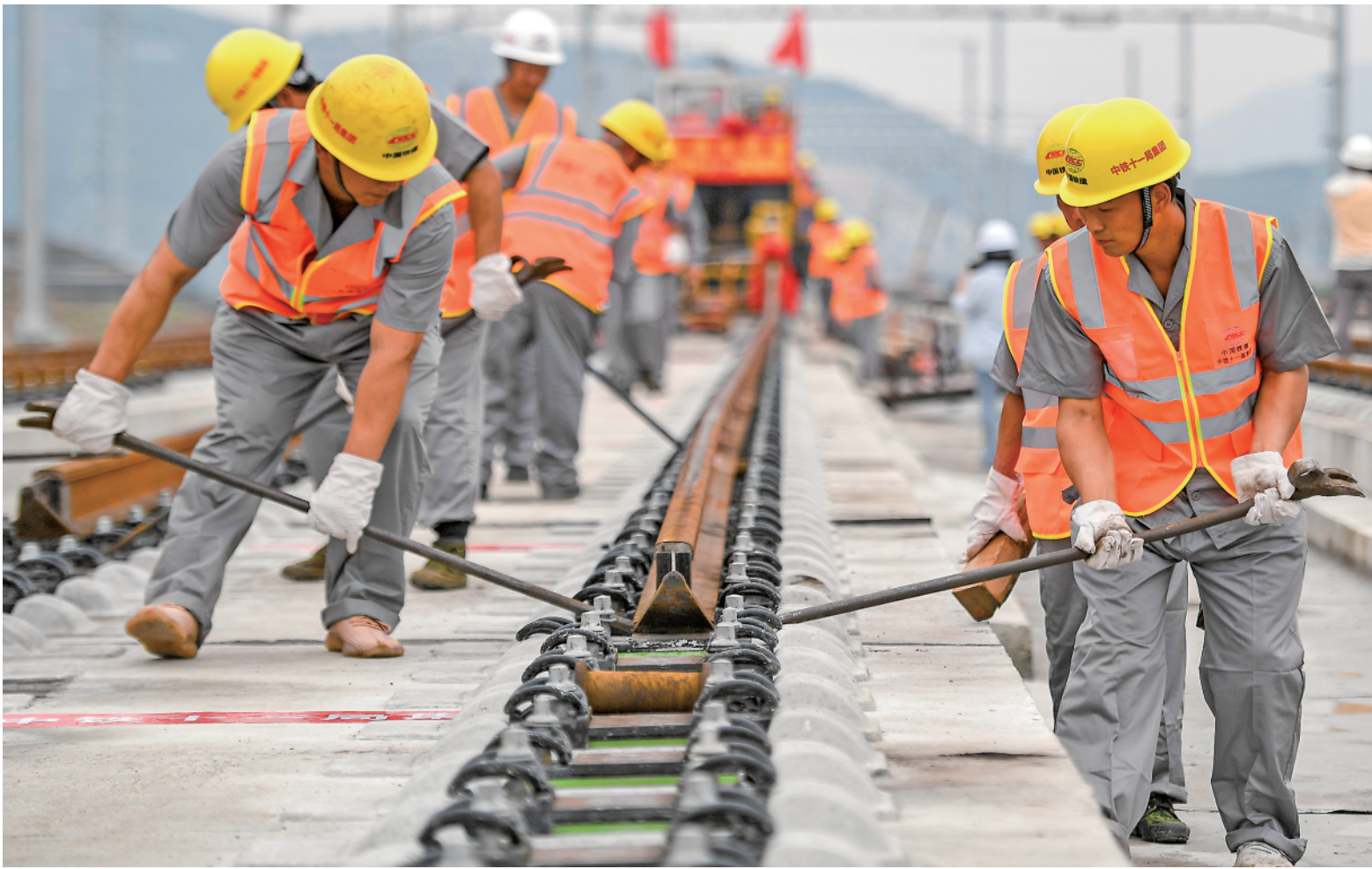
6月22日，中铁十一局的施工人员在杭绍台铁路上进行铺轨作业。
