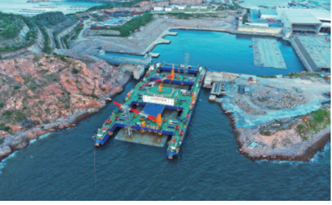
6月18日,深中通道海底隧道E10管节开始浮运安装。深中通道是继港珠澳大桥之后的又一超级工程。新华社发(董永贺摄)
