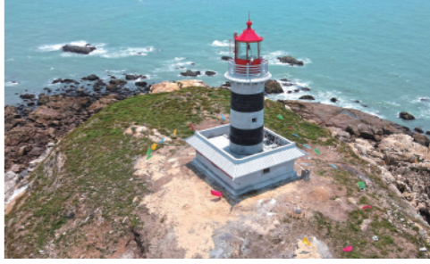
6月19日,地处我国沿海南北大通道、台湾海峡西侧内航路关键转向点的赤鼎屿灯塔正式投入使用。新华社记者魏培全摄
