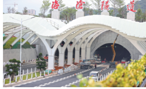
5月29日,工人在厦门海沧海底隧道出入口施工。该隧道预计6月建成通车,将成为福建省最长的海底隧道。新华社发(曾德猛摄)
