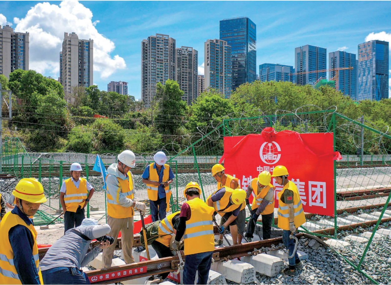
5月27日，中铁四局施工人员在深圳北站外将赣深高铁轨道对接至深圳北站线路南段（无人机照片）。当日，随着中铁四局铺轨机组将一对长轨与深圳北站线路南段成功对接，赣深高铁广东段南端大里程方向正线铺轨全部完成。 赣深高铁设计时速350公里，预计将于今年年底通车，届时赣州和深圳两地的通行时间将由目前最快6个小时左右压缩至2个小时以内。 新华社记者 刘大伟摄
