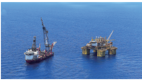
“深海一号”能源站是我国自主研发建造的十万吨级深水半潜式生产储油平台,落位于海南岛东南陵水海域的“深海一号”(陵水17-2)气田。 新华社记者蒲晓旭摄
