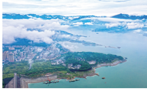
为迎汛期到来,三峡大坝上游湖北省宜昌市秭归县木鱼岛公园岸水位下降后消落带清晰可见(5月15日摄)。新华社发(郑家裕摄)
