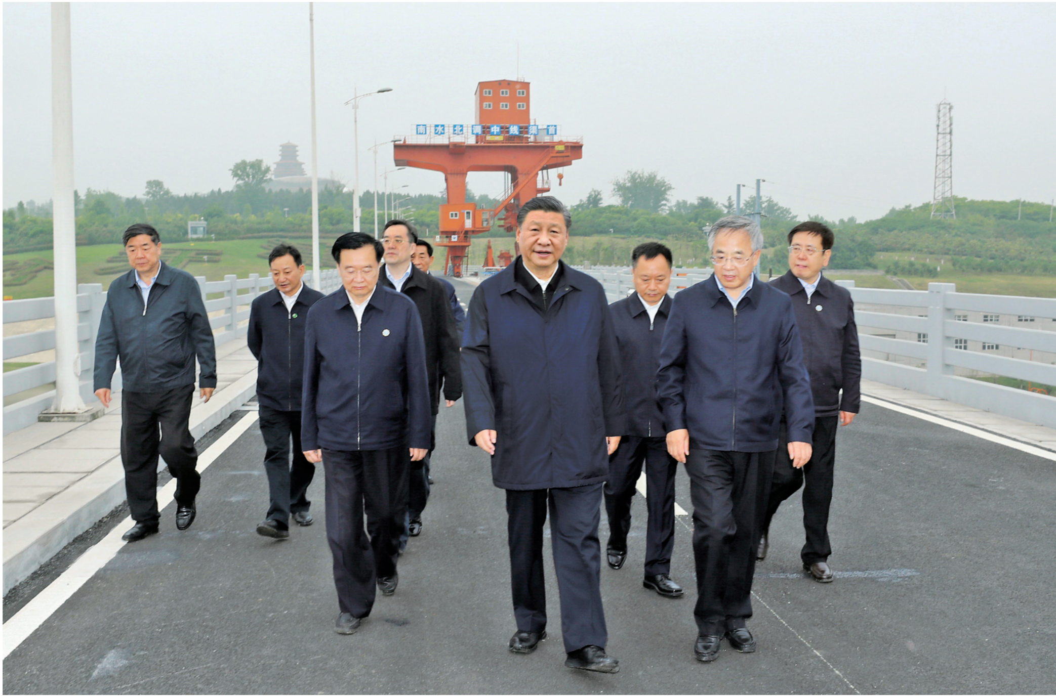
5月14日上午,中共中央总书记、国家主席、中央军委主席习近平在河南省南阳市主持召开推进南水北调后续工程高质量发展座谈会并发表重要讲话。这是座谈会前,习近平于13日在南阳市淅川县陶岔渠首枢纽工程考察。
