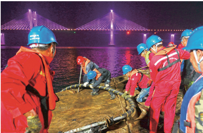
5月1日,国网福建电力海缆抢修人员将抢修好的电缆搬到船边准备吊入海底。 新华社记者林善传摄
