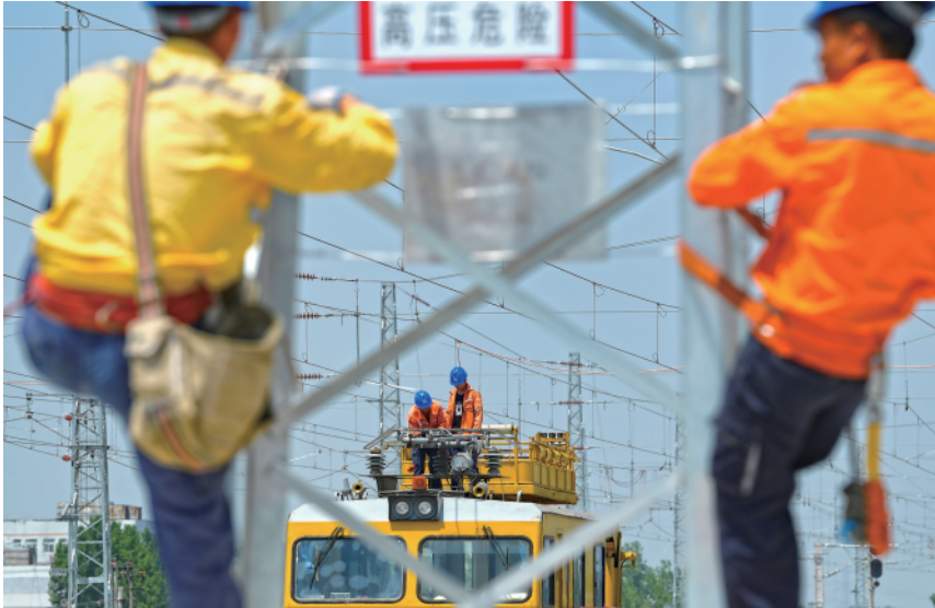
5月1日,中铁四局电气化公司施工人员在安徽合安外绕线进行接触网冷滑试验。 新华社发(潘星摄)
