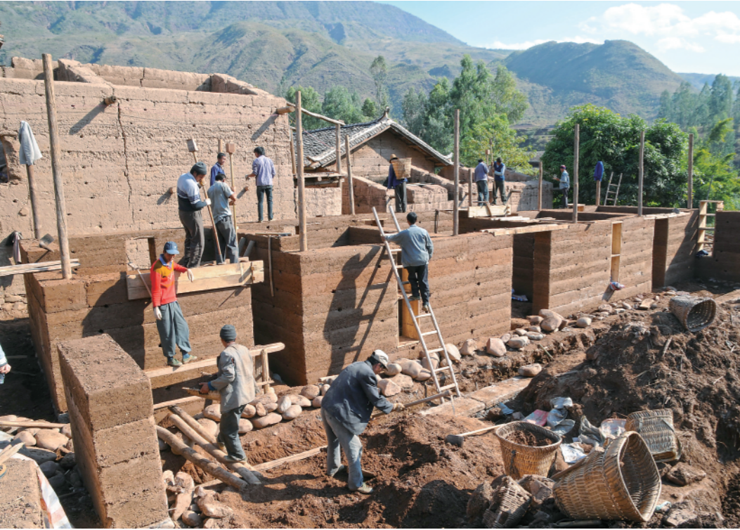
马鞍桥村村民在建造土房子。（受访者供图）
