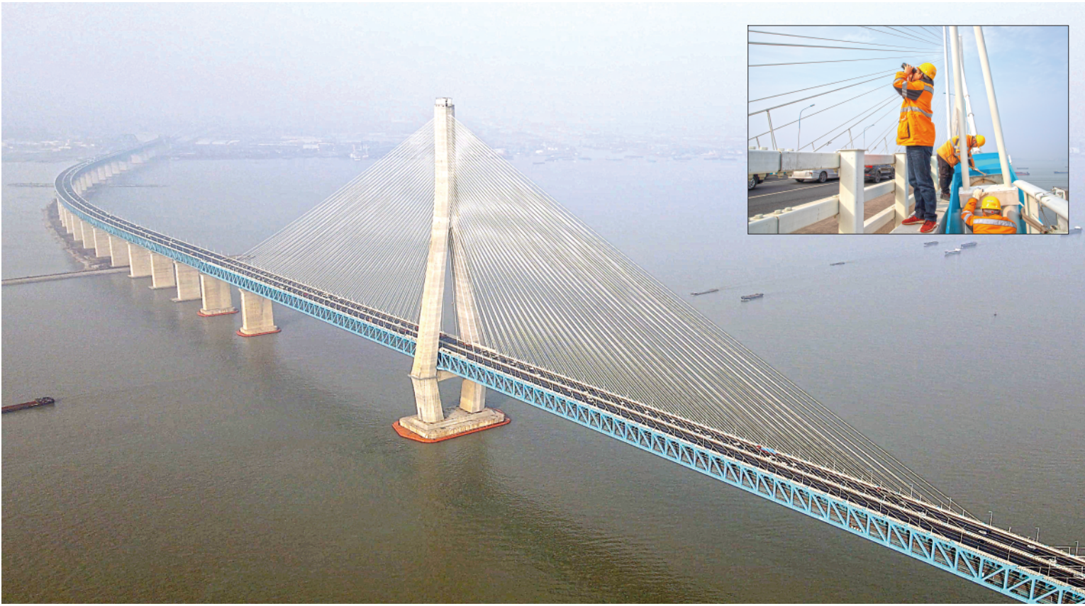
大图:沪苏通长江公铁大桥(无人机拍摄)。小图:1月27日,中铁上海局集团有限公司上海工务段检修人员在大桥公路面上检查大桥斜拉索。
