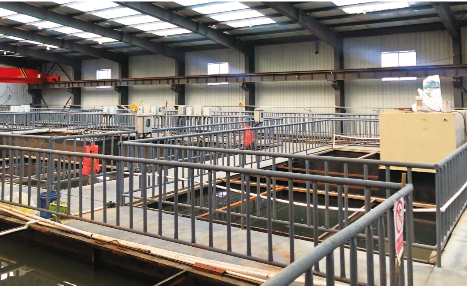
甘德县污水处理厂，污水曝气池安置在一个钢棚房内(2020年9月11日摄)。
