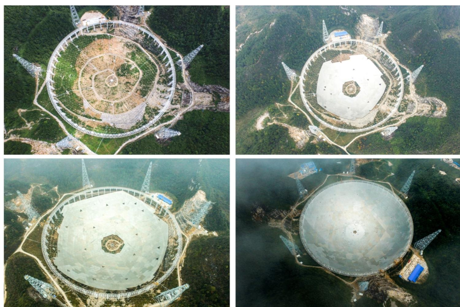
这是一张拼版照片，左上为FAST项目拼装第一块反射面板（2015年8月2日摄）、右上为FAST反射面板安装近半（2015年12月16日摄）、左下为FAST项目反射面板安装近八成（2016年3月9日摄）、右下为FAST项目反射面板安装完成（2016年7月3日摄）。
