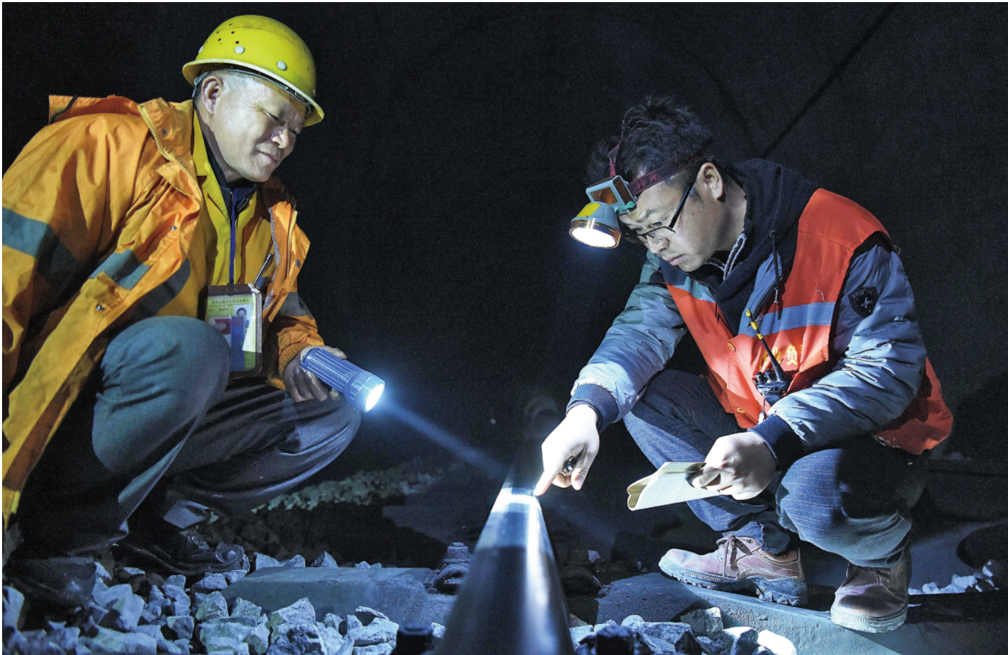
看守工廖成根(左)与工长罗昌伟检查隧道内钢轨轨面状态(1月30日摄)。在广西河池境内黔桂铁路线上的邓山隧道,中国铁路南宁局集团有限公司柳州工务段的4名看守工轮值值班,依靠手电筒在黑暗中穿行,及时巡查隧道中可能出现的各种隐患,确保每天经隧道运行的59趟客货列车春运安全。邓山隧道全长773米,是一个需要人员全天候看守的铁路隧道。
