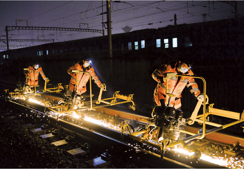
1月27日凌晨，上海铁路局芜湖工务段工人运用打磨机械和廓形测量等仪器，对芜湖站内高铁关键道岔、钢轨设备进行全面打磨。 新华社记者韩旭摄
