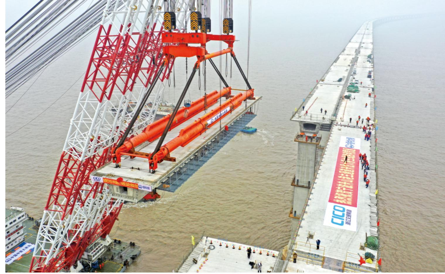
1月24日,大型浮吊船在放置最后一片预制箱梁(无人机照片)。
