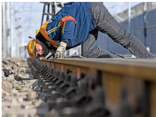
1月6日，中铁兰州局银川工务段职工进行铁轨测温作业。当日，宁夏银川市最低气温达到零下21摄氏度。
