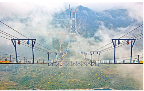
1月5日,贵州瓮开高速公路开州湖特大桥首根主缆索股架设完成,大桥正式进入主缆架设施工阶段。 新华社记者刘续摄
