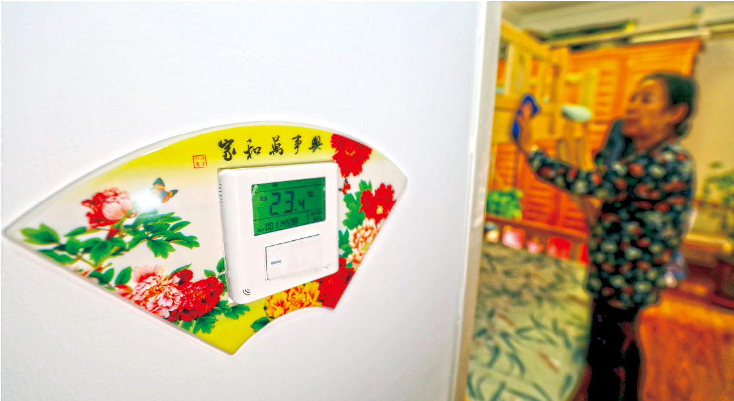
▲ 12 月 15 日，石家庄某小区居民家中，室温采集装置实时监测室内温度，并上传至供热管理中心智能化管理平台。新华社发（梁子栋摄）
