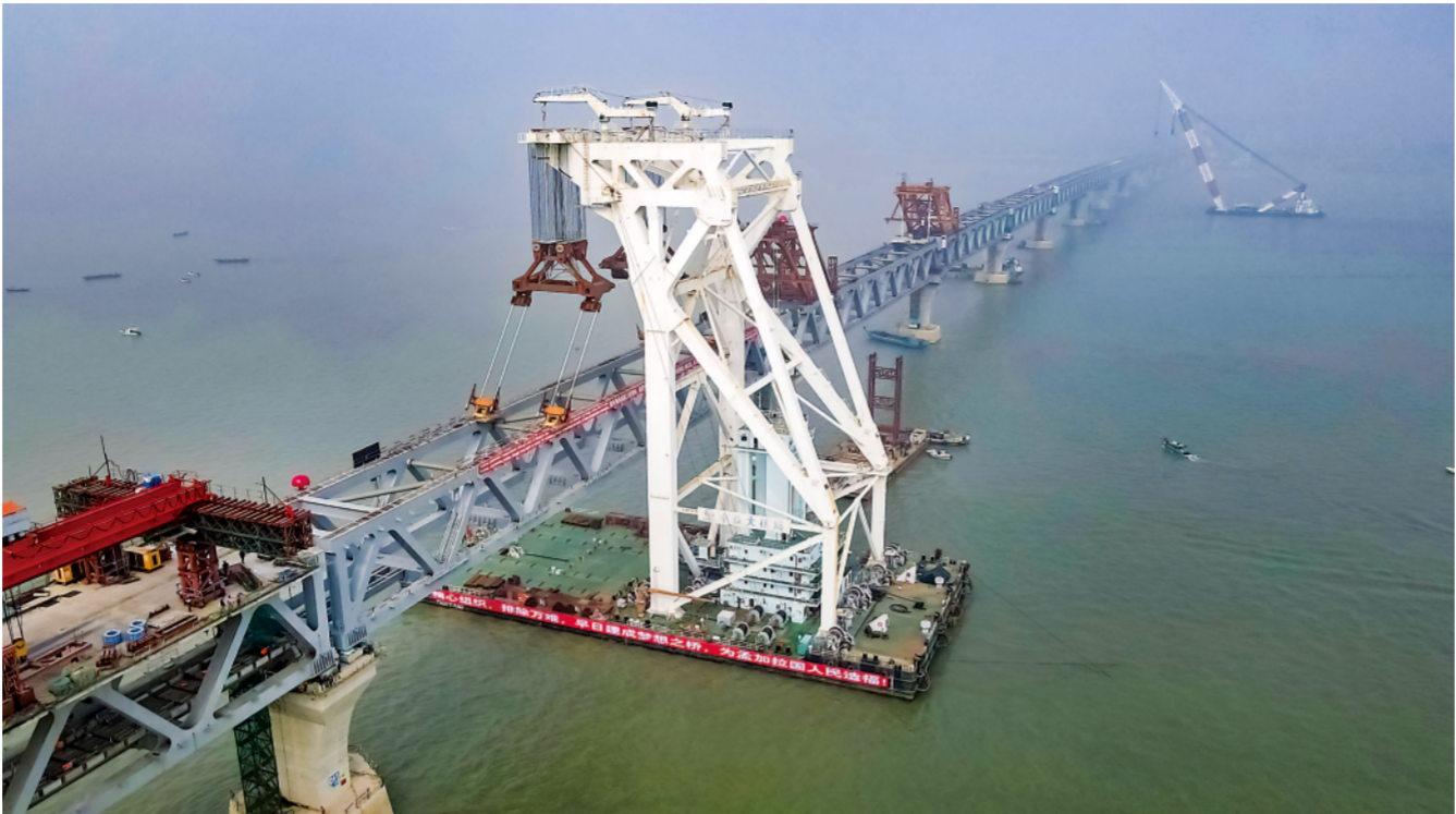
▲十二月十日，在位于孟加拉国首都达卡西南约四十公里处的帕德玛大桥项目现场，万吨级中心架梁起重船“天一号”将最后一跨钢架梁设到指定桥墩上。
