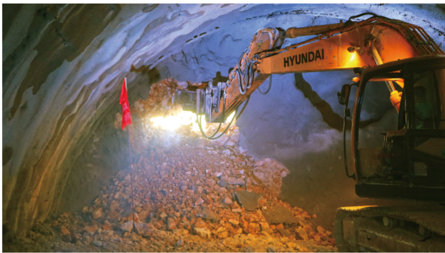
▲这是10月21日拍摄的中国建筑集团承建的波黑泛欧5C走廊高速公路波契泰利隧道贯通瞬间。新华社发(中建公司供图)
