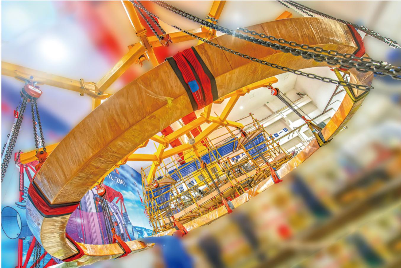
▲中核集团核工业西南物理研究院的工作人员在安装调试中国环流器二号M装置时起吊线圈(2019年9月16日摄)。新华社发
