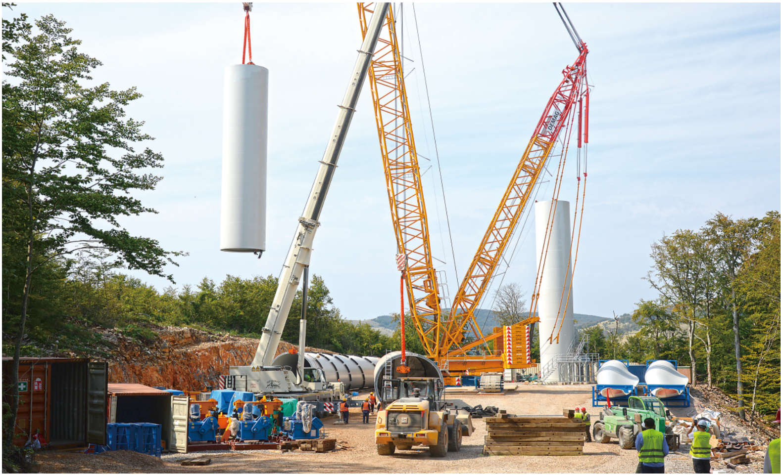
▲这是9月16日拍摄的克罗地亚塞尼风电项目风机塔筒吊装施工现场。
