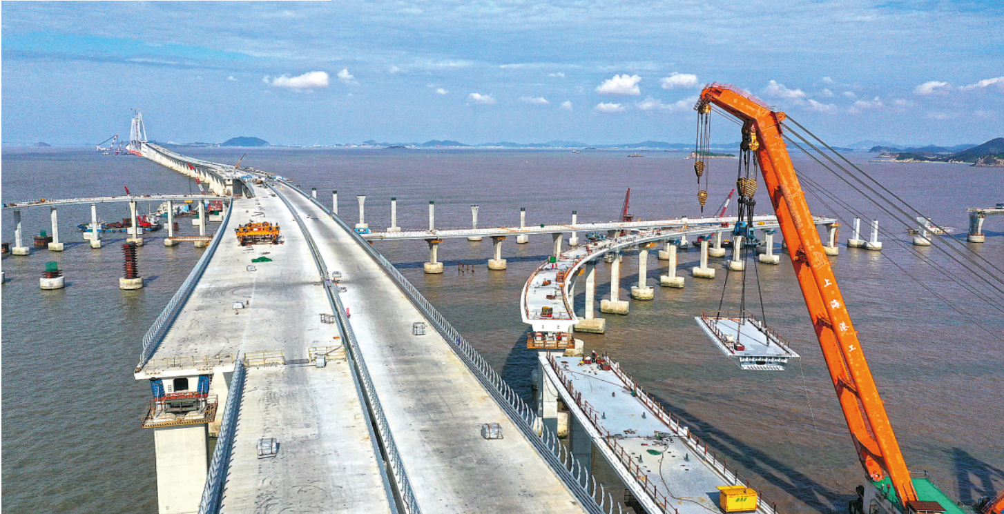
▲10月28日,浙江交通集团舟岱大桥海上互通(长白互通)D匝道施工区的最后一块箱梁顺利吊装完成。 新华社发(姚峰摄)
