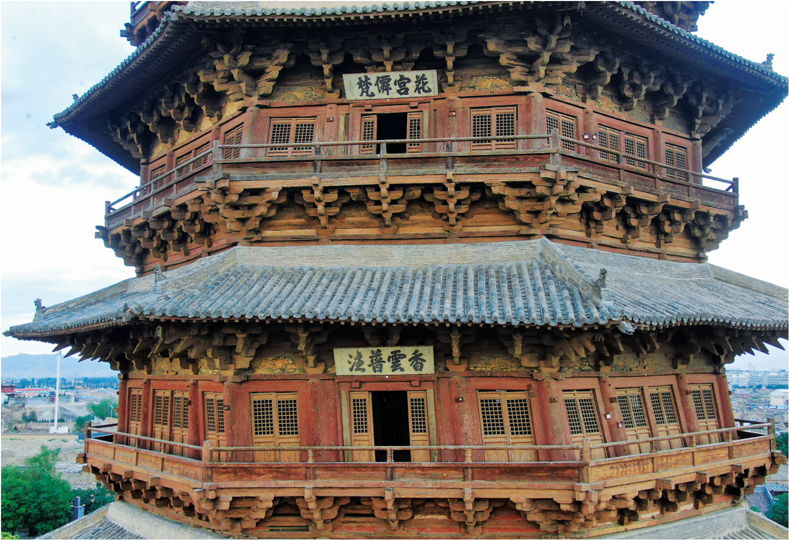
▲从外观看，应县木塔二层西面屋檐明显下沉，柱子向内倾斜。 本报记者徐伟摄
