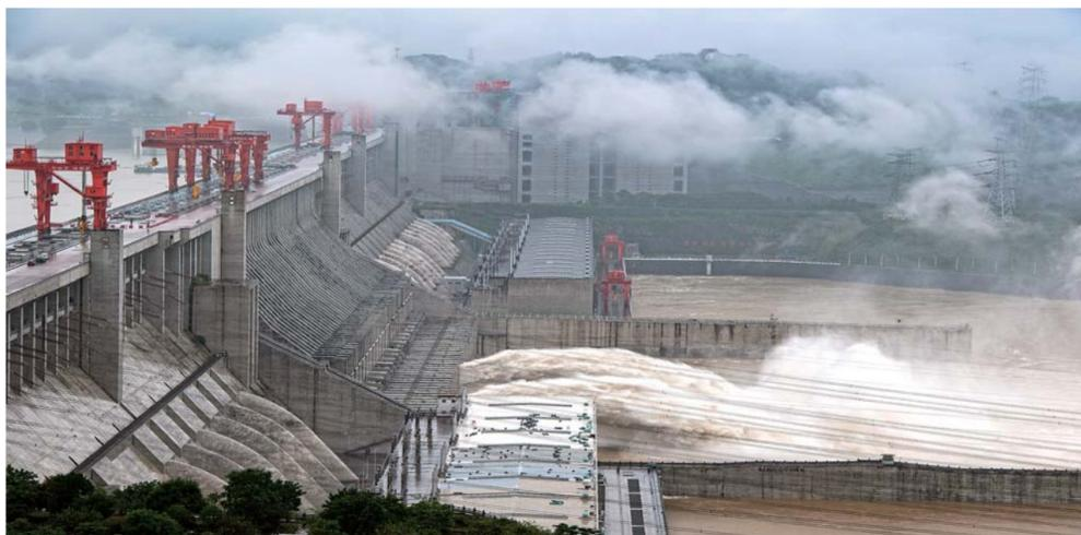
▲7月17日傍晚,三峡大坝开启泄洪深孔泄洪。近日长江上游干流及三峡区间来水明显增加,三峡水库入库流量快速上涨,7月17日10时达到50000立方米/秒。根据全国主要江河洪水编号规定,此次来水达到洪水编号标准,“长江2020年第2号洪水”在长江上游形成。预计17日20时三峡水库最大入库流量在55000立方米/秒左右。新华社发(郑家裕摄)
