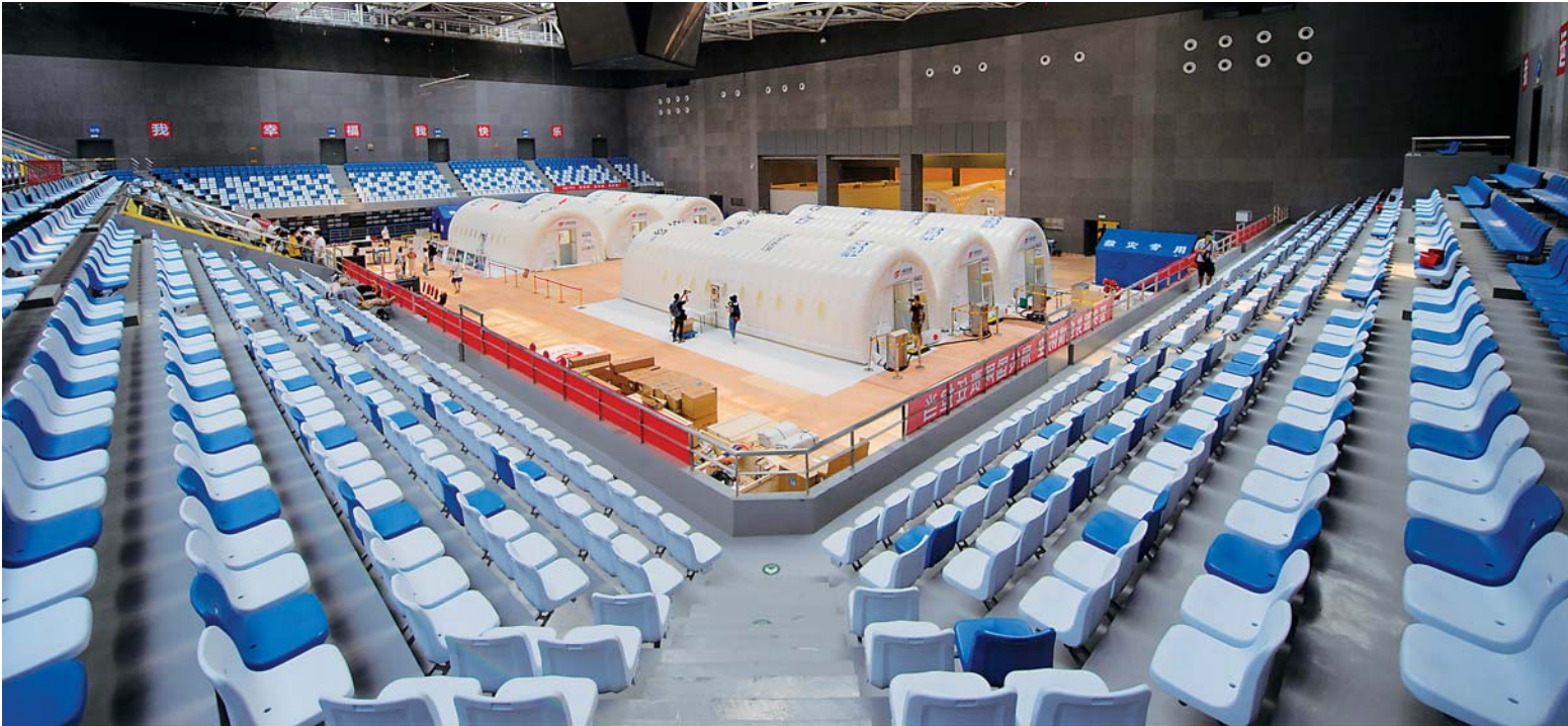
▲这是6月23日拍摄的北京首座气膜版“火眼”核酸检测实验室。
