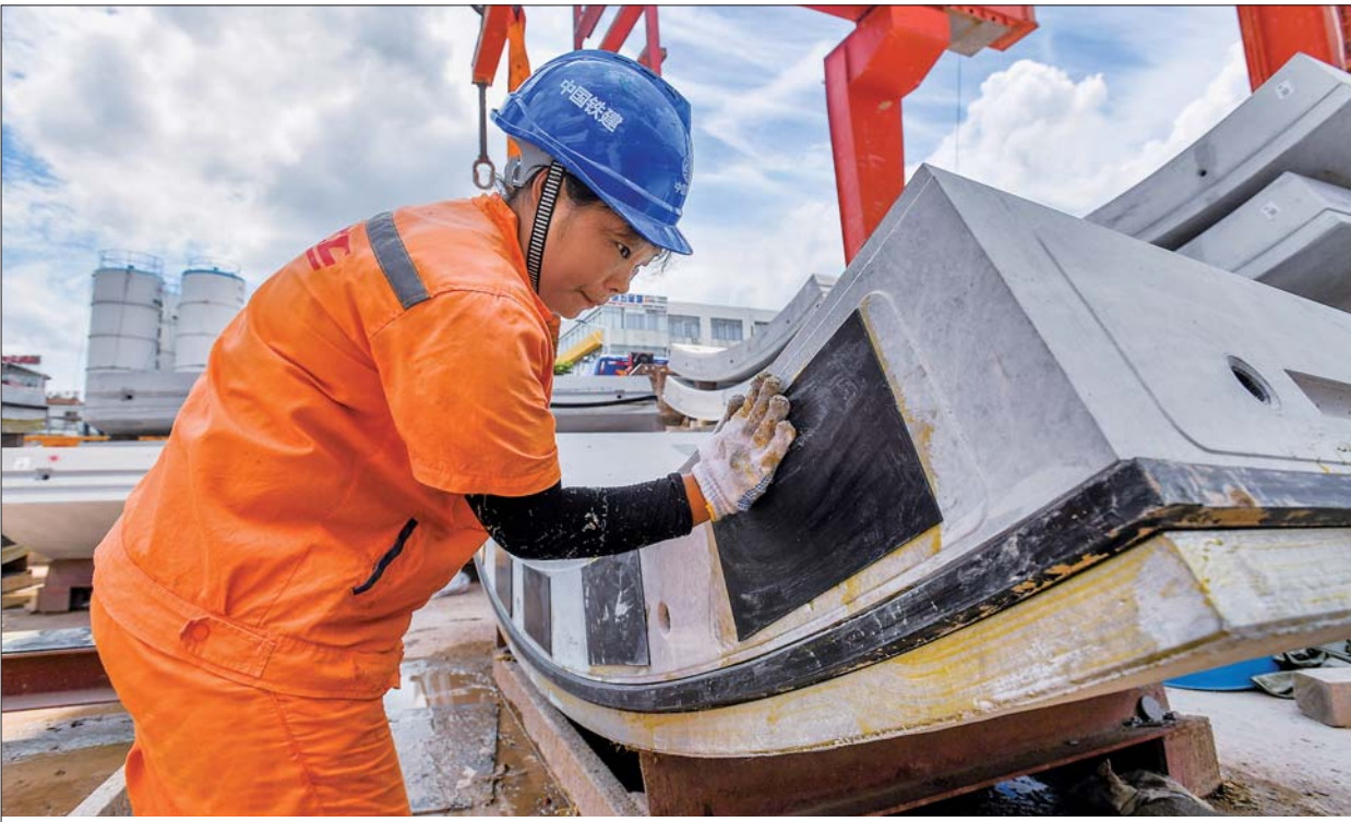
▲6月26日,中铁十一局员工在陇枕出入场线施工现场安装盾构管片橡胶止水带。当日,中铁十一局在广州地铁18号线陇枕出入场线实现盾构月掘进541.6米,该区区间隧道弯度和线路纵坡都接近地铁设计曲线、坡度极限值,盾构难度大,是18号线最大的“拦路虎”。广州地铁18号线是粤港澳大湾区重点基础设施建设项目,连接广州市中心城区与南沙自贸区,设计最高时速160公里。 新华社记者刘大伟摄
