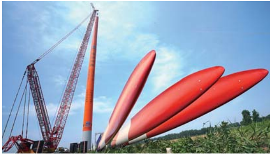
滦河口风电二期：吊装风机
