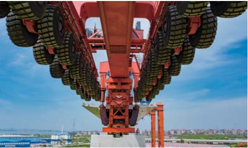
福厦高铁：运架一体架箱梁
