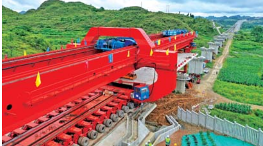
贵南高铁加紧建设
