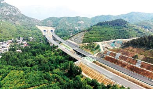
济泰高速施工冲刺
