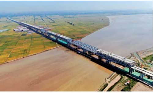
郑济铁路郑州黄河特大桥合龙
