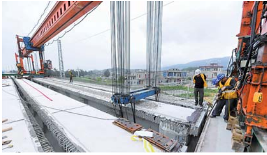
福平铁路全线桥梁架设完成
