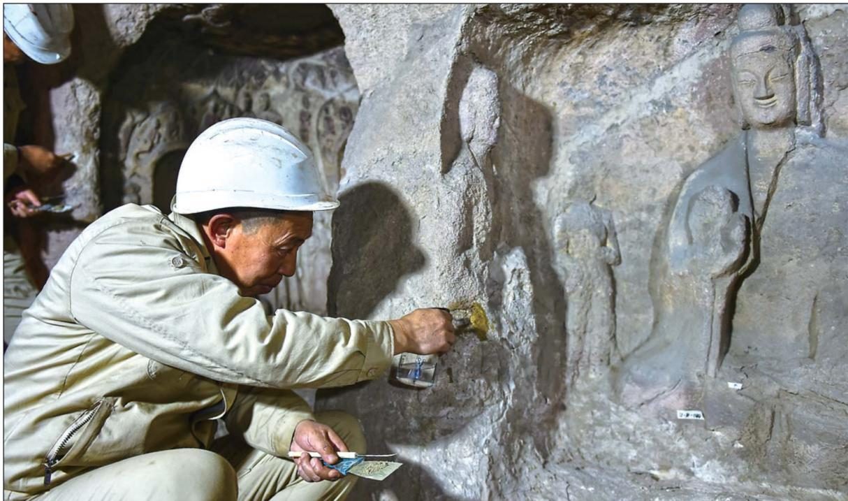
▲5月10日,在山西省大同市,工作人员对云冈石窟进行维护保养。云冈石窟是我国三大石窟之一。2019年8月,云冈石窟保护修复研究室开始进行第11-13窟的保养工作,针对粉尘、裂隙、空鼓、分离等问题进行有效治理,预计2020年底完成。
