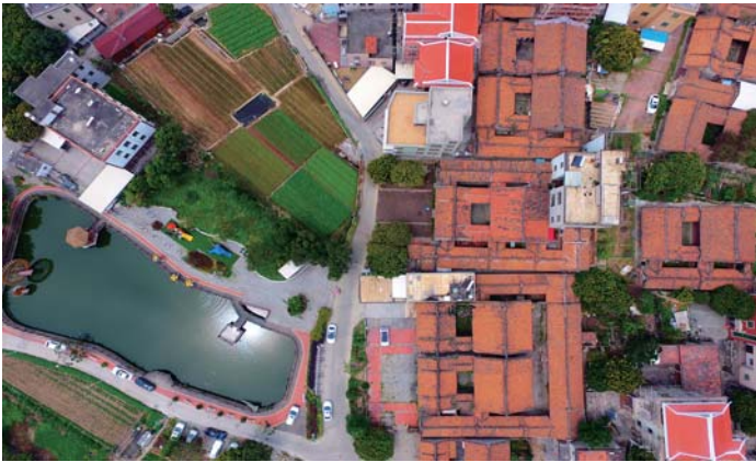
▲ 4月26日，位于厦门漳州交界处的青礁村航拍全景。
